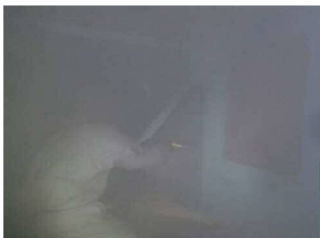
従来ブラスト工法の施工状況 → 粉じんが多く、視界が遮られている
