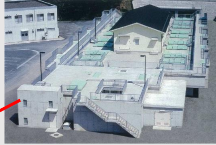
上向流式生物接触ろ過施設
