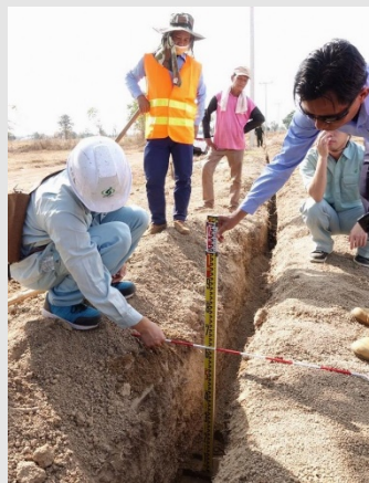
▲JICA 草の根技術協力事業 (水道管布設現場における支援状況)
