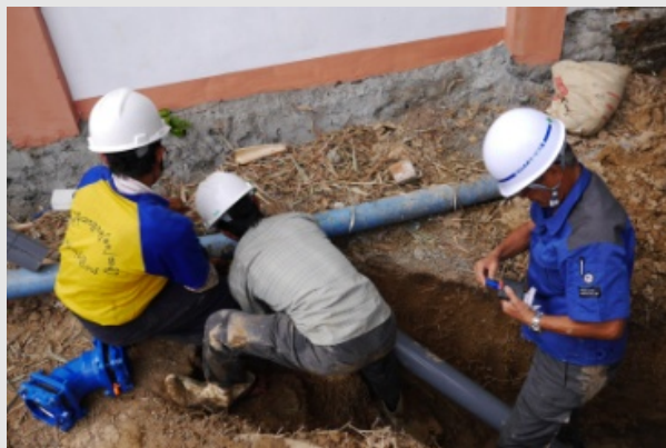
←現地で水道管を取替
