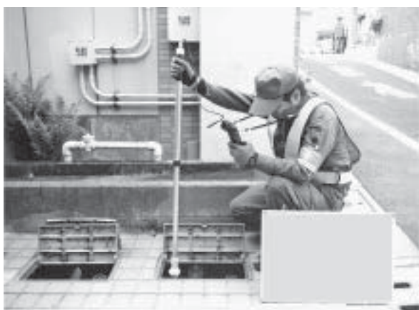
写真5 各戸音聴調査（時間積分式漏水発見器）
