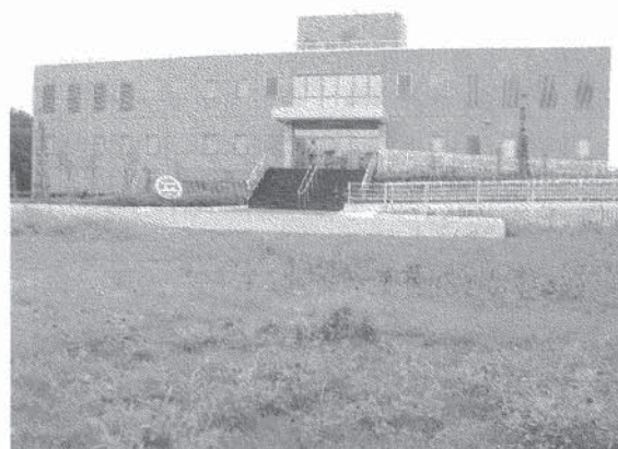
写真1 砧浄水場膜ろ過棟
