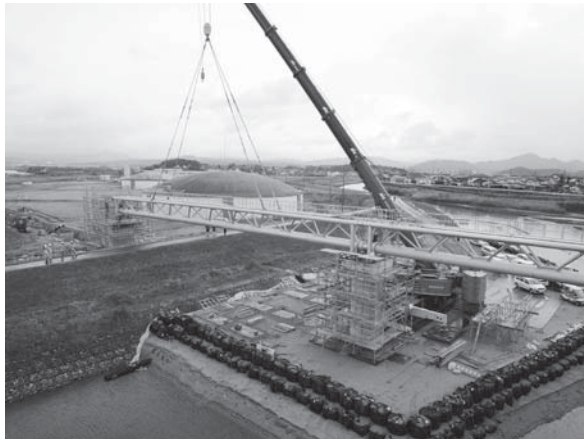
工事中の水管橋の写真①
