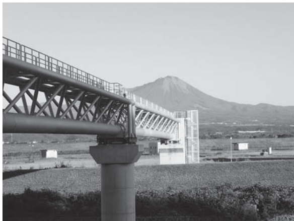
完成した水管橋と正面に秀峰大山
