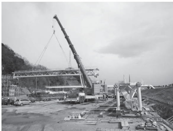
工事中の水管橋の写真②
