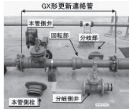
写真1 更新連絡管の部品名称
