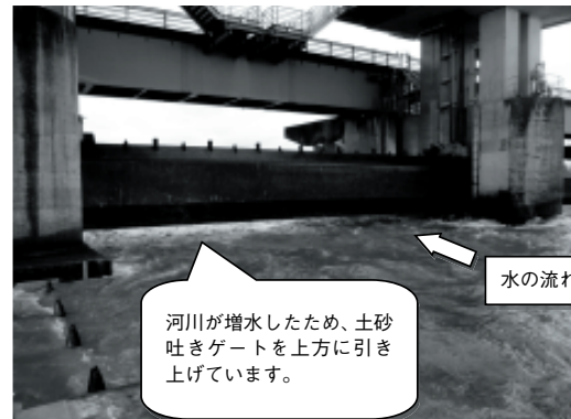
図1 土砂吐きゲート外観(引き上げ時)
