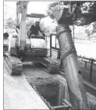
写真1 廃塩ビ管の撤去作業
