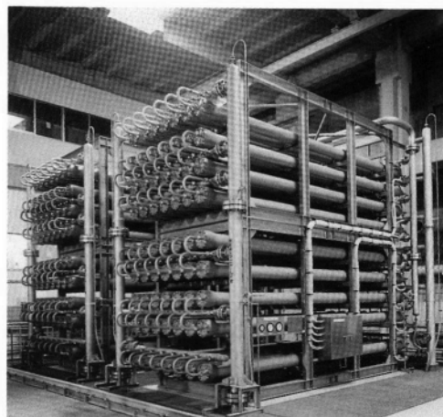
造水能力1万m 3 分のユニット
