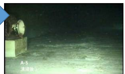
清掃後: 床面の点検が可能となる
