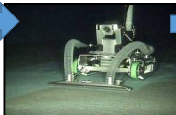
清掃中: 底版の沈澱物の吸引排出
