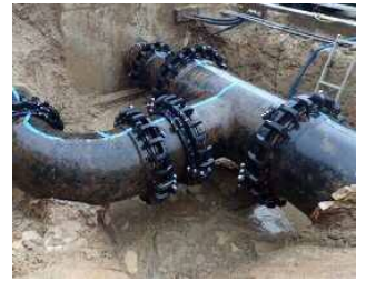
本管：K形1000,800,600mm 分岐：K形800mm
