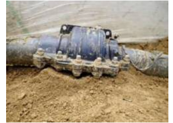
K形 150mm施工例(実験)
