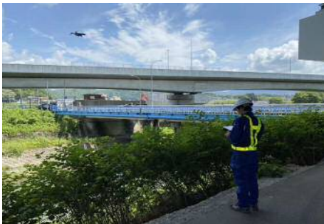
図1 ドローンによる点検風景
