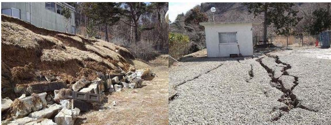
ろ過池下流側のブロック積擁壁の崩壊
