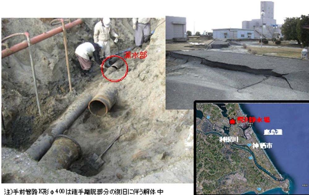
注)手前管路環形φ400は継手離脱部分の復旧に伴う解体中
