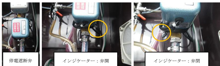
写真-3. 停電遮断弁作動状況（参考）
