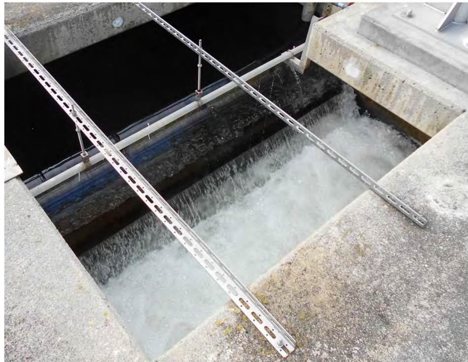
着水井越流堰と混和池へつなぐ開渠
