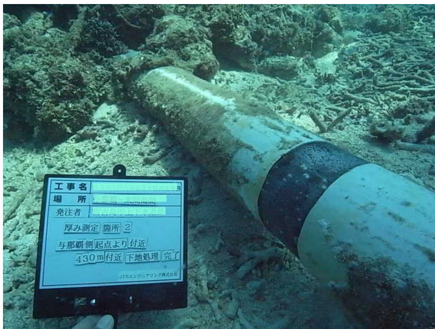
①外面被覆の剥し
