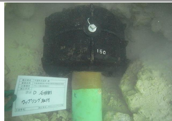
袋ジョイント設置状況
