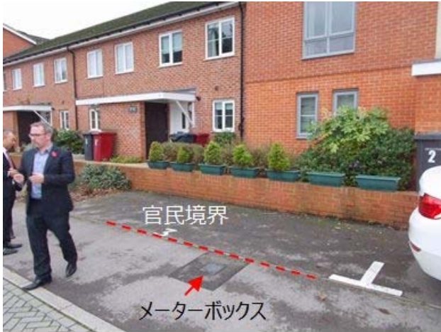
図 13 メーター敷設現場 [レディング市, JWRC 撮影]
