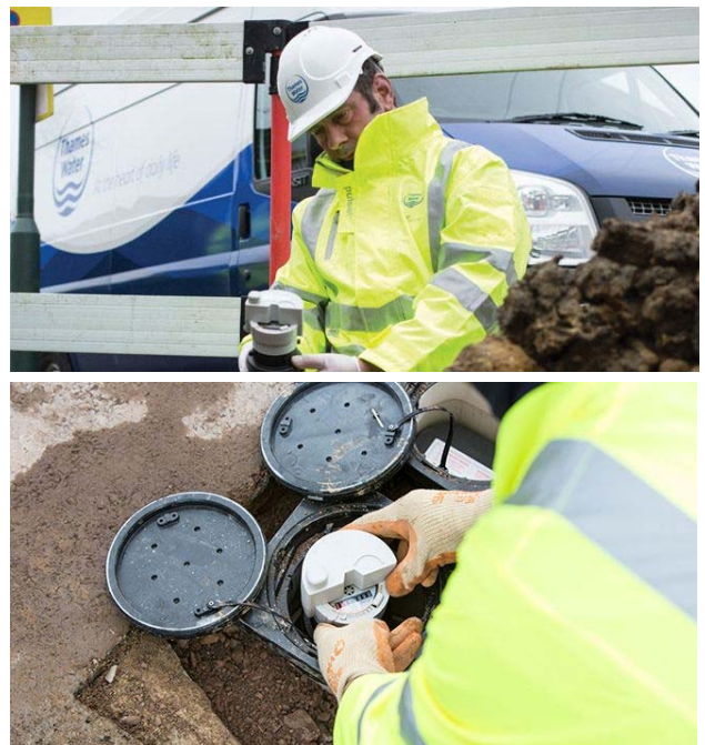
図 11 テムズウォーター社のスマートメーター初号機設置の様子(2015. 9. 30 同社 Web サイトより)
