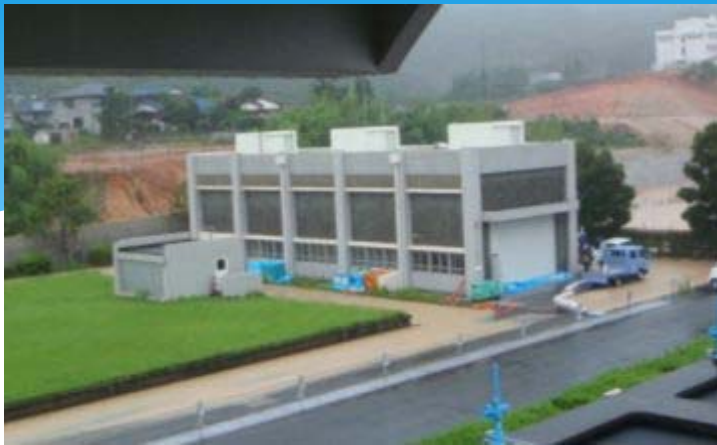
乙金浄水場配水停止前(7月24日 21:00)
