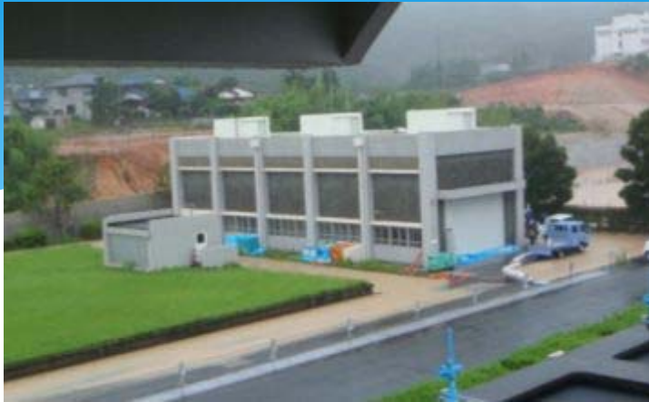
乙金浄水場配水停止前（7月24日 21:00）
