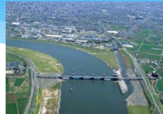
筑後大堰(久留米市)
