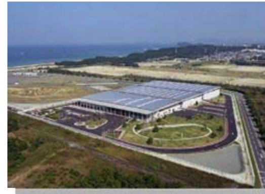
海水淡水化センター
