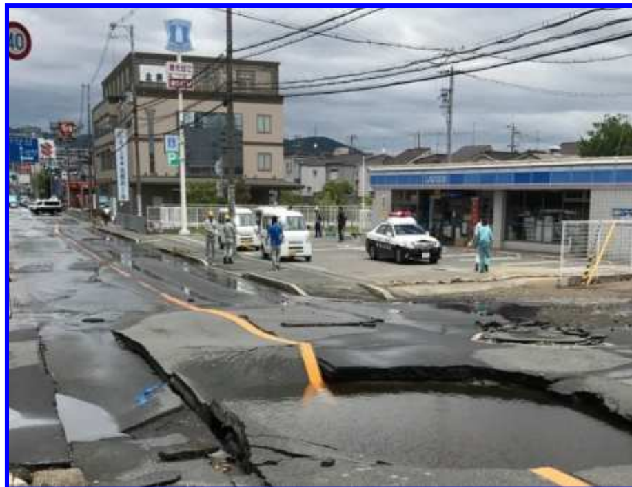
バルブ閉操作後 (6/18 12時頃)
