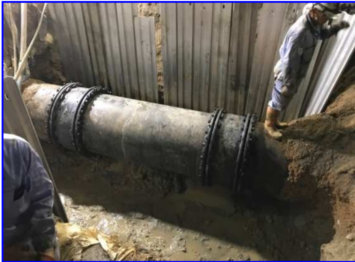
破損箇所復旧（6/19 3時頃）
