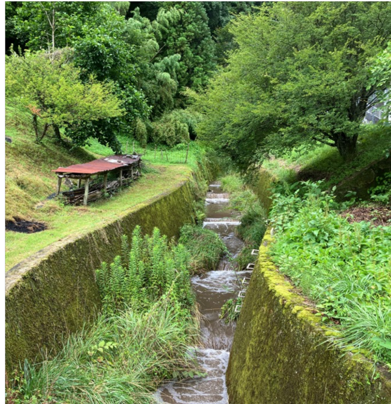
出水時（雨天時）
