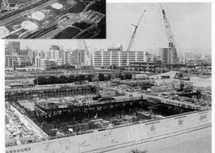
▲建設中の高度浄水処理施設
