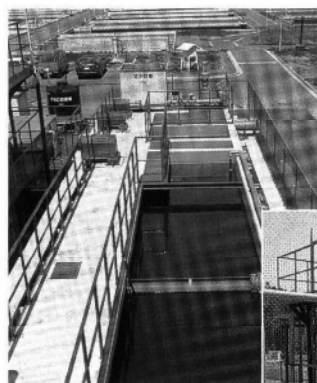
▲凝集沈でん池
