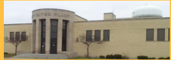
水処理施設 出典：フリント市（事業体）
