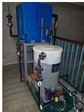
写真 7-3 二段凝集の PAC 注入設備の実例
