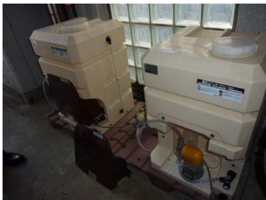
写真 7-3 二段凝集の PAC 注入設備の実例
