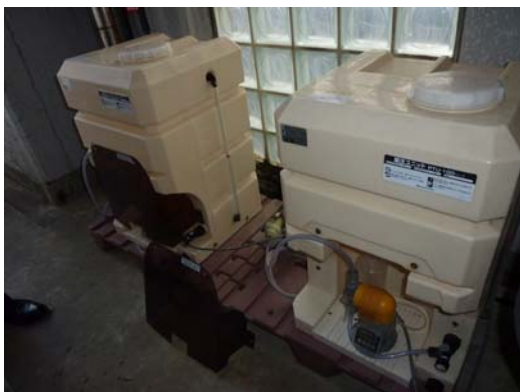
写真 7-3 二段凝集の PAC 注入設備の実例
