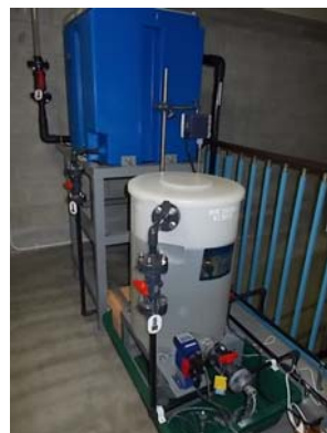
写真 7-3 二段凝集の PAC 注入設備の実例
