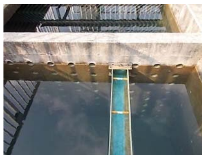
写真 7-1 タラップと整流孔
