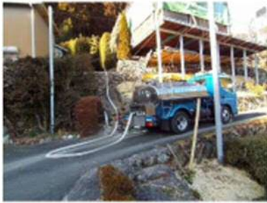
① 給水車設置
