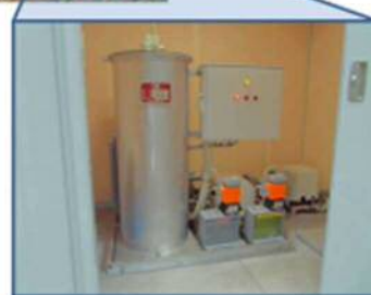
沢水専用小型浄水装置
