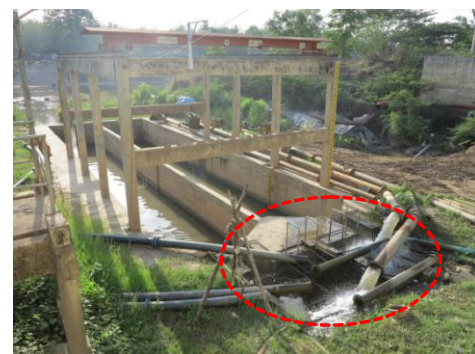
(d) Inflow of water intake channel
