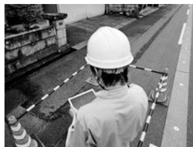
写真3 現場での使用状況
