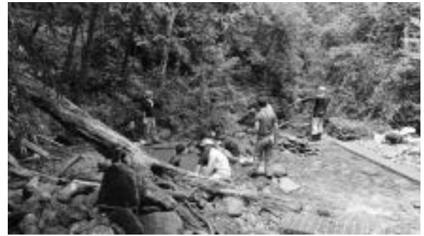
写真3 職員による土砂除去の様子
