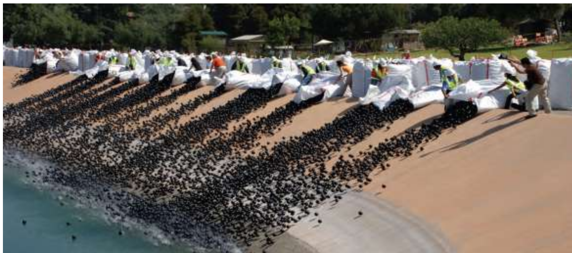
写真1 シェイドボールを流し入れている様子
